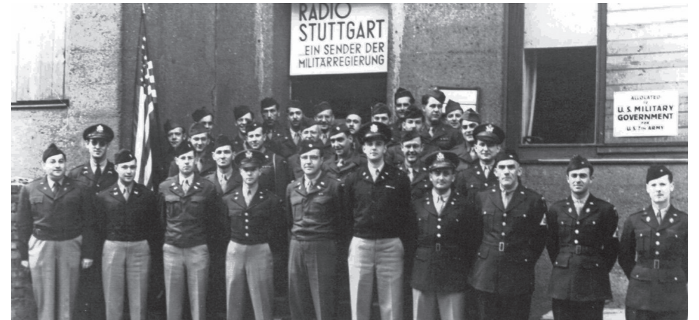
Die amerikanische Mannschaft von Radio Stuttgart im Eingang des ehemaligen Telegrafengebäudes, 1945
